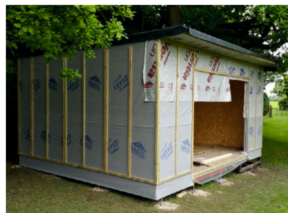
Battens put onto membrane wrap.
